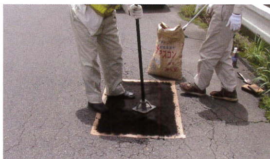
⑤作業車による仕上げ転圧
